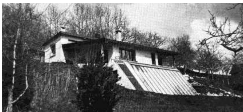
Figure 68 : Maison aux Adrets conçue par P. Lavigne et équipée d'un système à thermosiphon. (J.-P. Ménard, Maisons solaires. Premiers bilans , Paris : Le Moniteur, 1980, p. 195)
