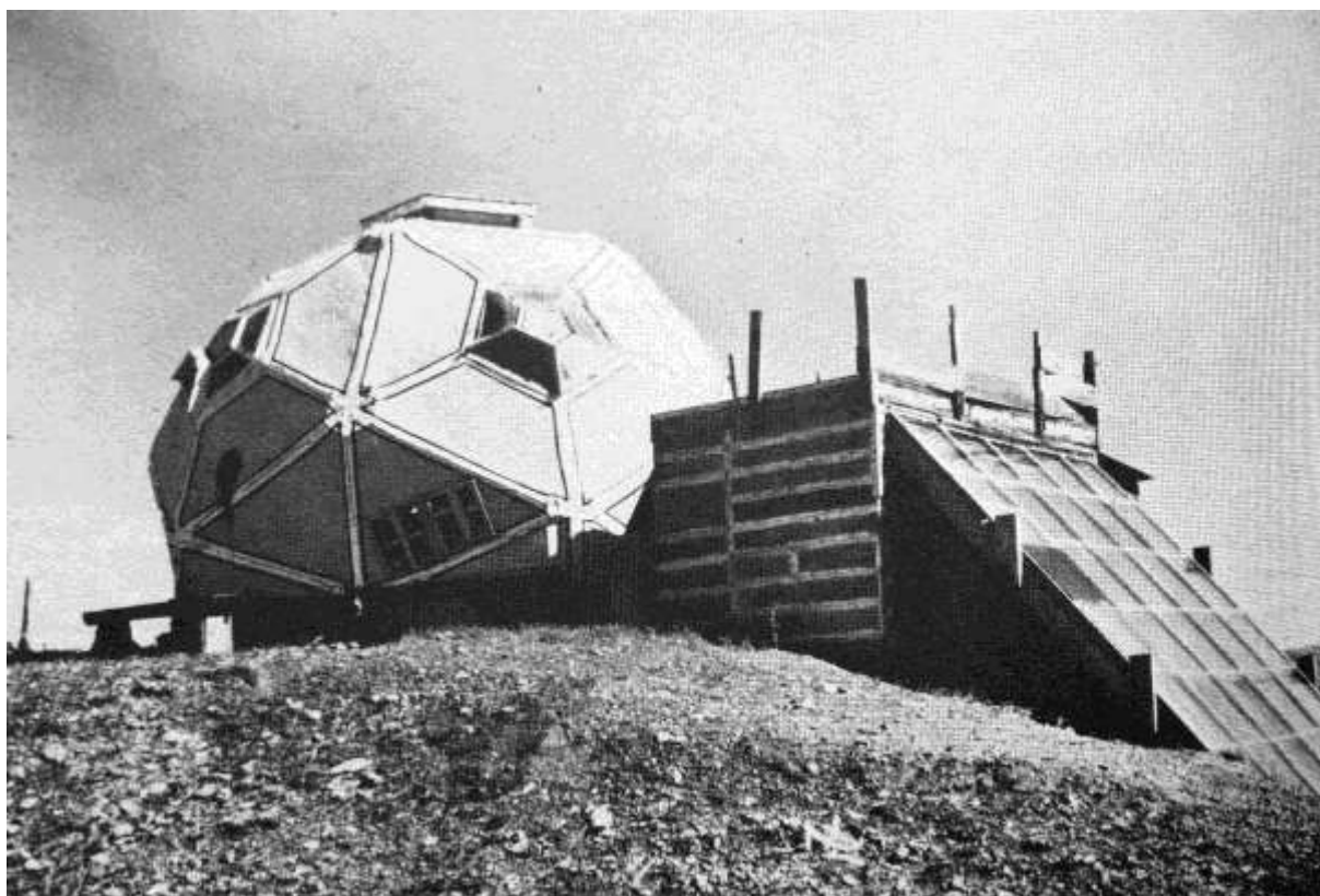
Figure 64 : Capteur à air fabriqué à partir de vitres récupérées pour le chauffage d'un dôme à Drop City. (Centre de Création Industrielle/Centre Georges Pompidou, Énergies libres ! , Paris : CCI/Centre Georges Pompidou, 1976, p. 34.)
