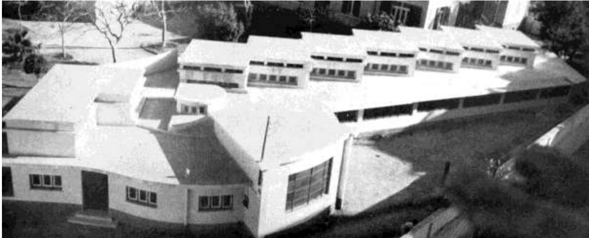
Figure 84 : « Toits parasols » de l'hôpital français de Suez conçu par Ayoub. (R. Ayoub, « Contrôle thermique naturel des locaux dans les tropiques et les régions tempérées et ensoleillées », Techniques & Architecture , 20 ème série, n°2, février 1960, p. 133)
