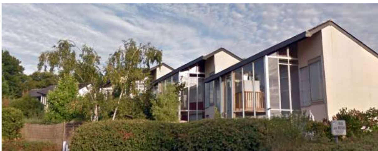
Figure 127 : HLM des « Basses Fouassières » conçus par J.-R. Mazaud et C. Parant, assistés par M. Cabanat et B. Sésolis. On remarque que les stores blancs sont baissés et occultent les murs Trombe en journée. (Google Street View, consulté le 24 novembre 2021)
