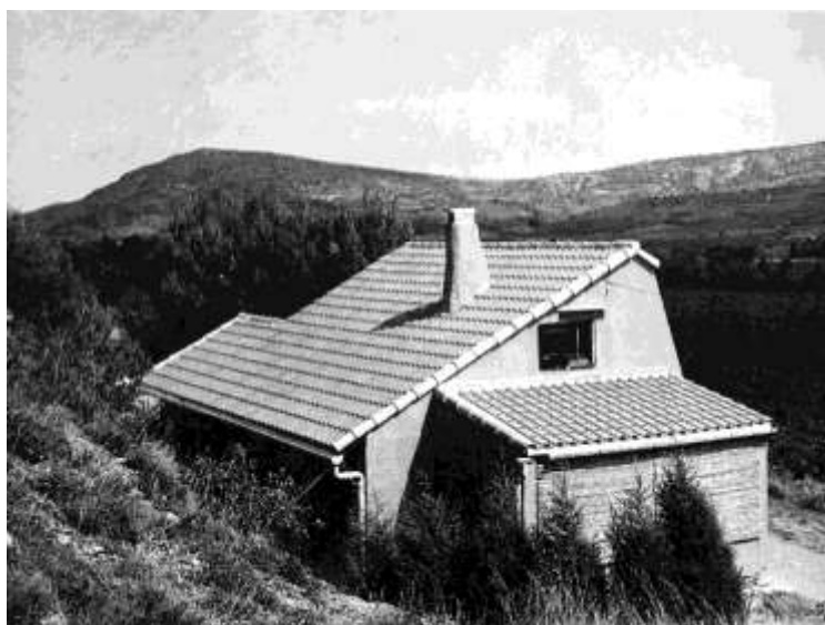
Figure 74 : Angle nord-ouest de la maison conçue par B. Laignelot à Montlaur. (J.-P. Ménard, Maisons solaires. Premiers bilans , Paris : Le Moniteur, 1980, p. 97)
