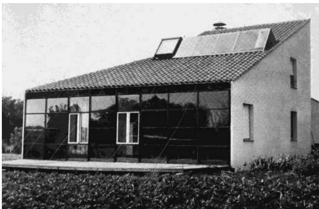
Figure 60 : Construction en Vendée équipée d'un mur Trombe et de panneaux isolants et réflecteurs empruntés au système Drumwall. (J.-P. Ménard, Maisons solaires. Premiers bilans , Paris : Le Moniteur, 1980, p. 59)
