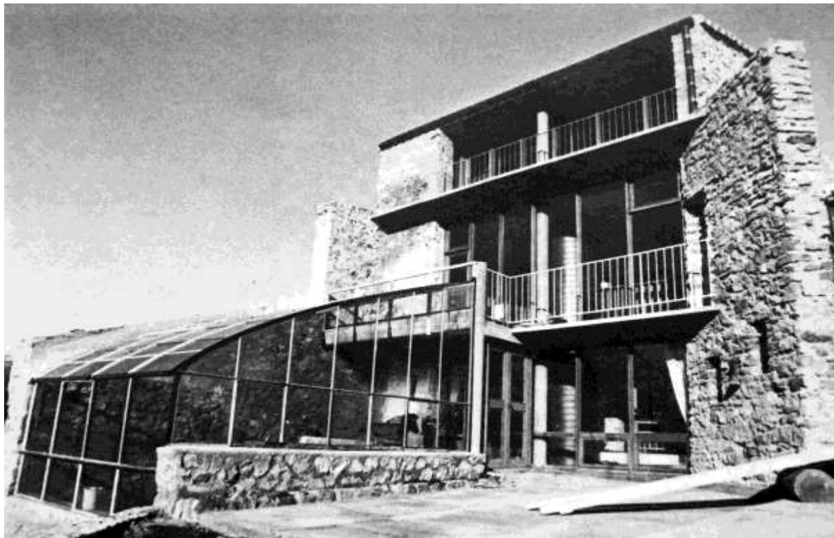
Figure 118 : Serre de la maison des Perdrigals conçue par M. Gerber particulièrement inconfortable en été. (M. Gerber, « Trois maisons bio-climatiques dans l'Aude », Techniques & Architecture , « Les 4 éléments », n° 325, juin-juillet 1979, p. 66)
