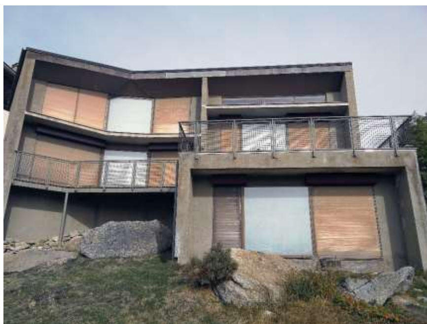
Figure 61 : Murs thermiques (en blanc) dans une construction conçue par M. Gerber. (photo Clément Gaillard, le 17 octobre 2019)
