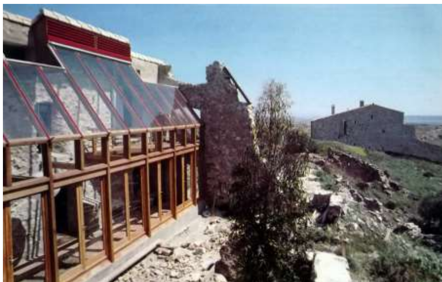
Figure 119 : Serre de l'atelier conçu par M. Gerber et P. Pous sujette à des surchauffes malgré les possibilités de ventilation.
