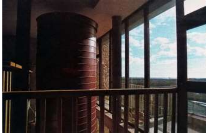
Figure 45 : Colonne d'eau de 5 m 3 dans la maison des Perdrigals de Michel Gerber. (M. Gerber, « Trois maisons bio-climatiques dans l'Aude », Techniques & Architecture , « Les 4 éléments », n° 325, juin-juillet 1979, p. 66)
