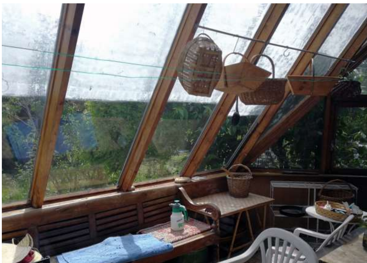
Figure 121 : Serre d'une maison conçue par J.-P. Cordier peinte au blanc d'Espagne par l'habitante afin de limiter la pénétration du rayonnement solaire estival et limiter les surchauffes. (photo Clément Gaillard, le 23 mai 2019)
