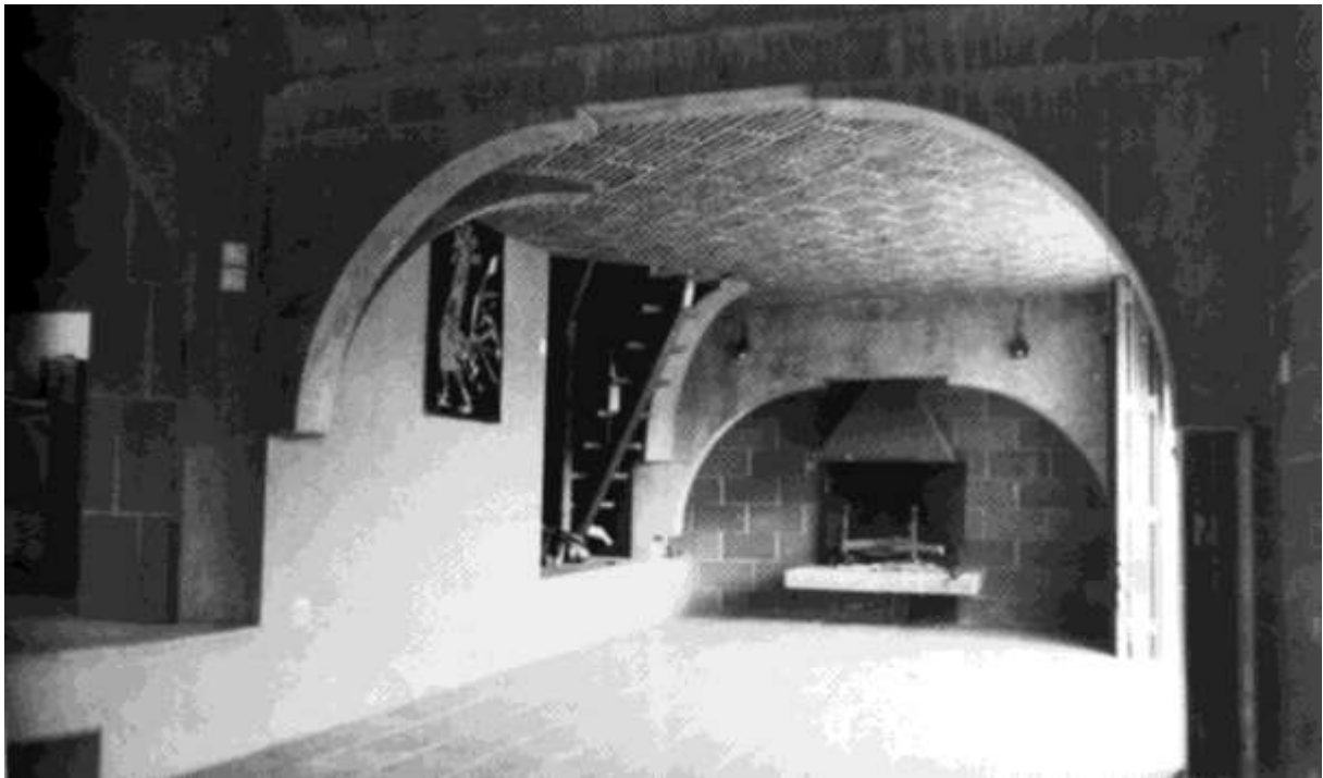
Figure 108 : Intérieur de la maison conçue par J.-P. Cordier. On remarque le plafond formé de briques creuses éclatées au marteau. ( L'Architecture d'Aujourd'hui , « Solaire : passif ou actif ? », n° 209, juin 1980, p. 53)
