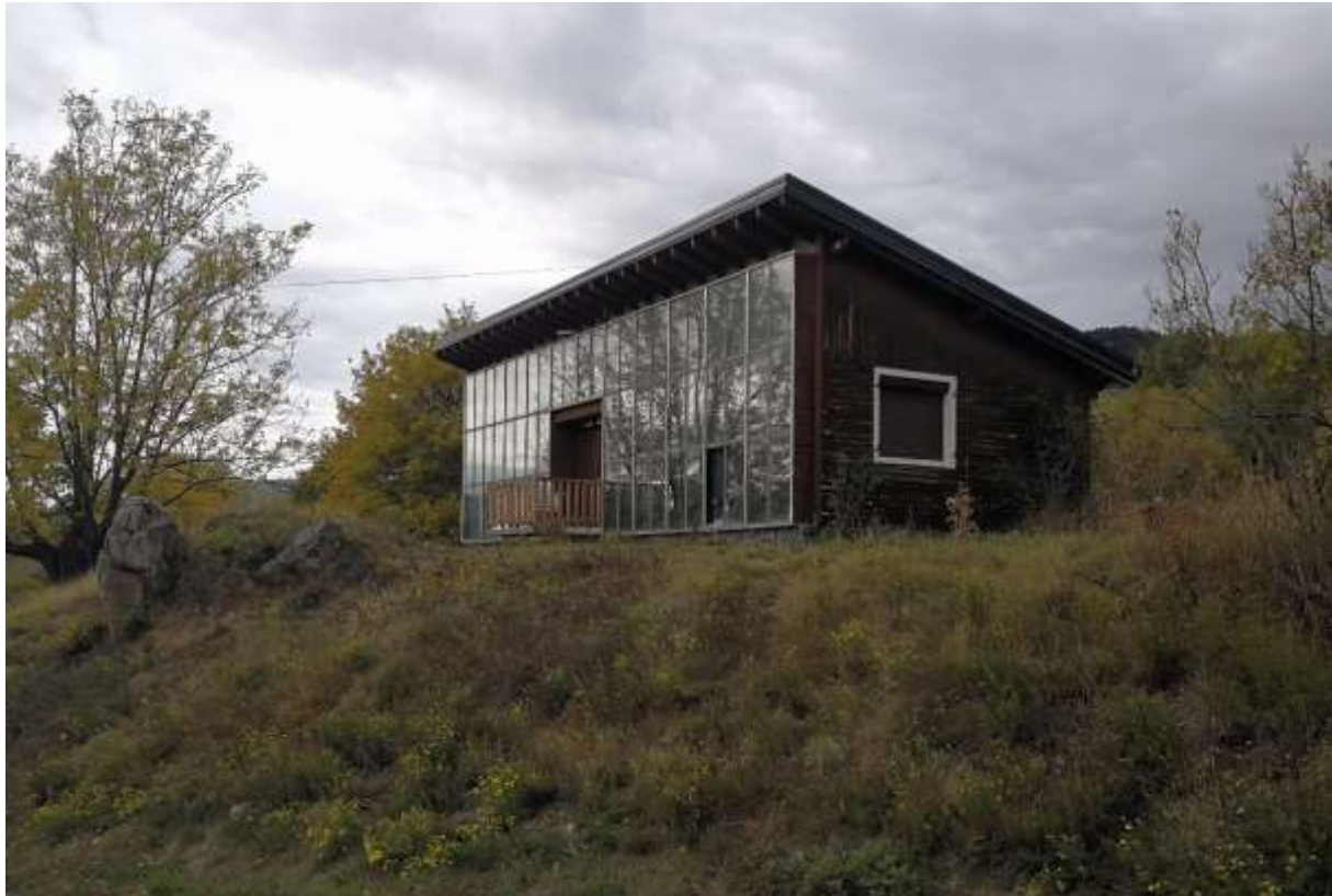
Figure 54 : Maison à mur Trombe de 1967. (photo Clément Gaillard, le 18 octobre 2019)
