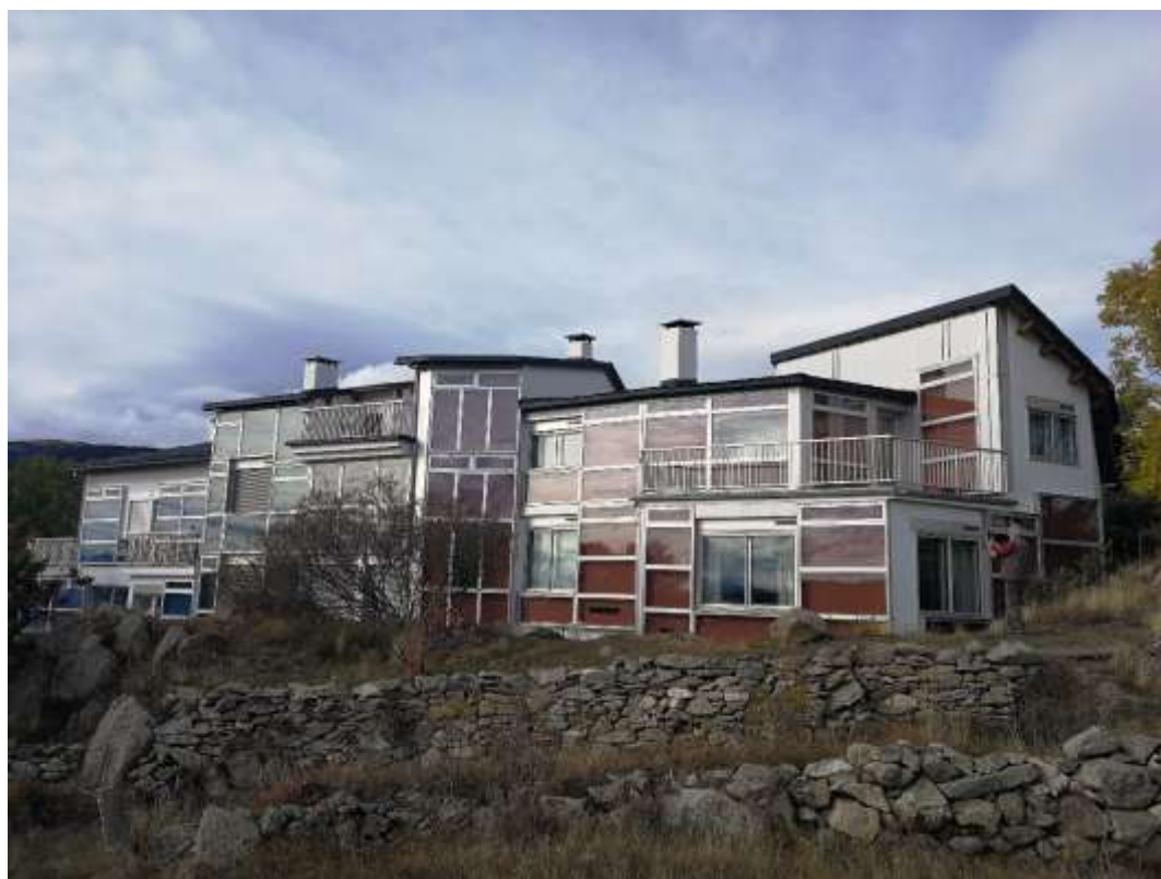
Figure 55 : « Maisons des ingénieurs » de 1974 équipées de murs Trombe-Michel. (photo Clément Gaillard, le 18 octobre 2019)
