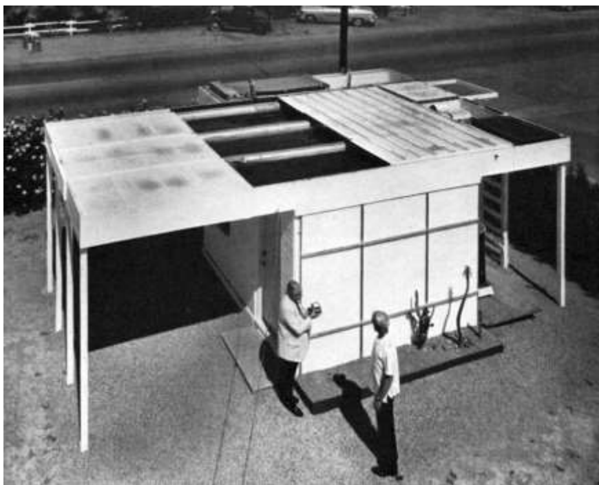
Figure 93 : Prototype d'habitation conçu pour tester le système Skytherm à l'Université de Phoenix. (H. R. Hay, J. I. Yellott, « International Aspects of Air Conditioning with Movable Insulation », Solar Energy , vol. 12, 1969, p. 430)
