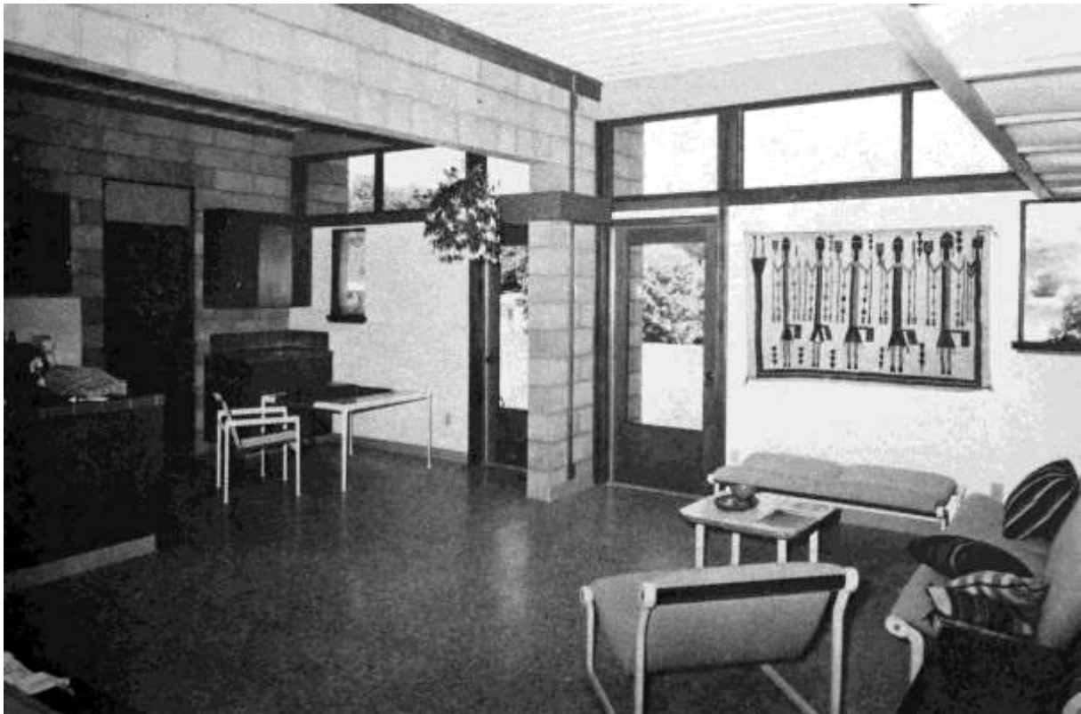
Figure 95 : Intérieur de la maison d'Atascadero. On remarque que le plafond blanc est formé de tôles métalliques nervurées pour favoriser les échanges thermiques. (B. Anderson, M. Riordan, The Solar Home Book: Heating, Cooling and Designing with the Sun , Harrisville : Cheshire Books, 1976, p. 138)
