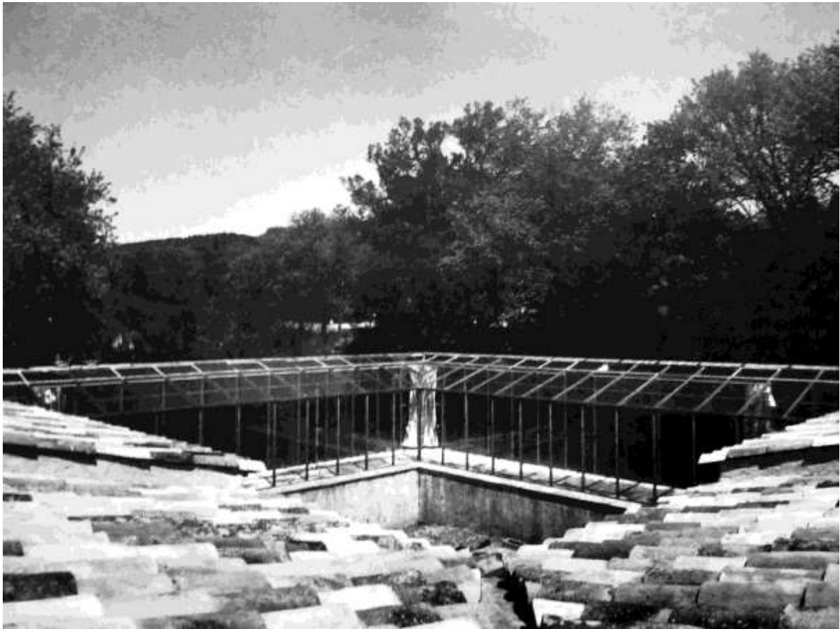
Figure 123 : Serre d'une maison à Nice orientée au sud-est et au sud-ouest et thermiquement très inconfortable en été. (J.-P. Ménard, Maisons solaires. Premiers bilans , Paris : Le Moniteur, 1980, p. 119)
