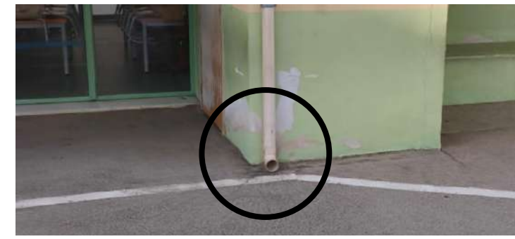
Descente de gouttière inutilisée au nord de la cour
